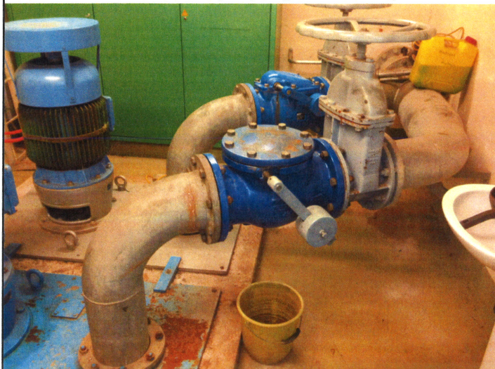
Vieillesse des pompes (plus de 30 ans)
