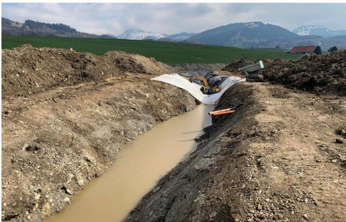
**Mesures** : mise à ciel ouvert de la conduite enterrée pour éviter le débordement du lac, étude hydrologique et hydraulique pour définir l'augmentation du diamètre de la conduite et le secteur de la prise d'eau, pose de la nouvelle conduite enterrée, remise en état et indemnisation du propriétaire concernant la perte pour inconvénients d'exploitation.
