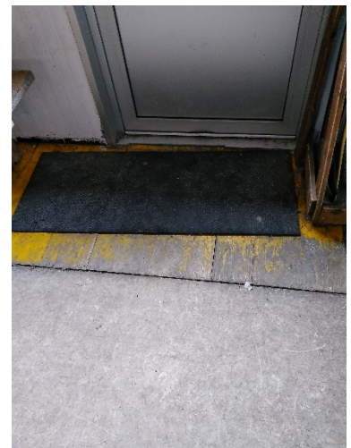
Vestiaire Hockey : renforcement entrée
