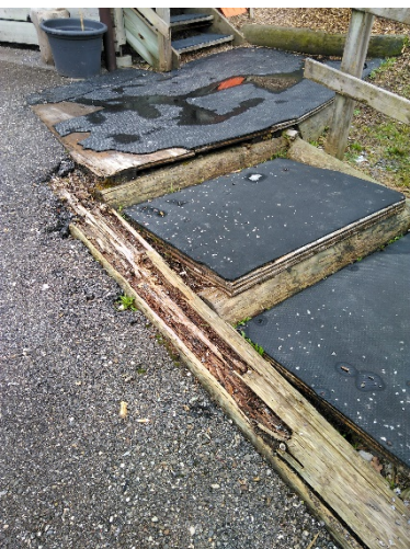
Escalier d'accès à la cuisine
