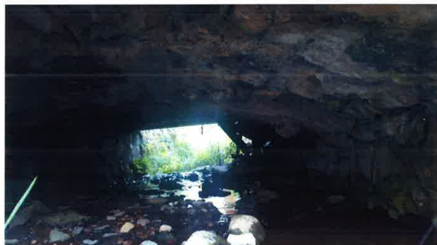
Voûte du pont
