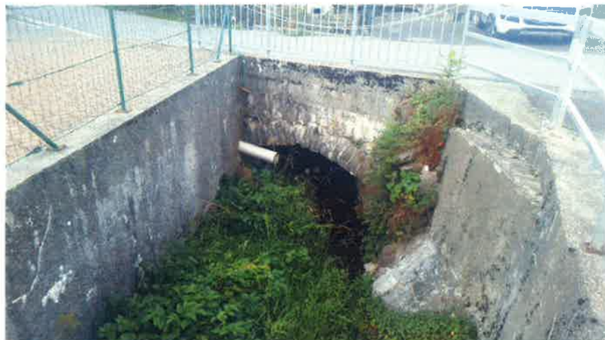
Vue du côté amont du pont
