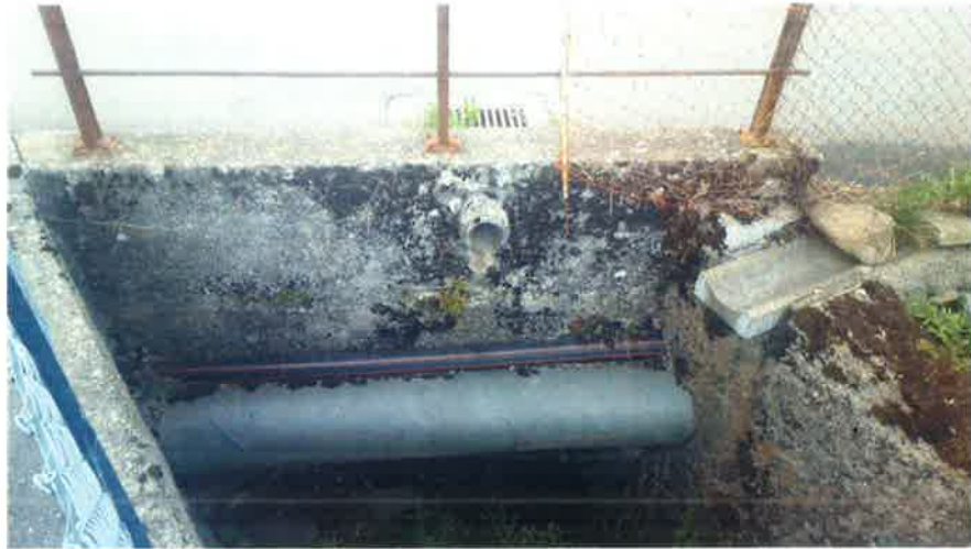
Vue du côté aval du pont
