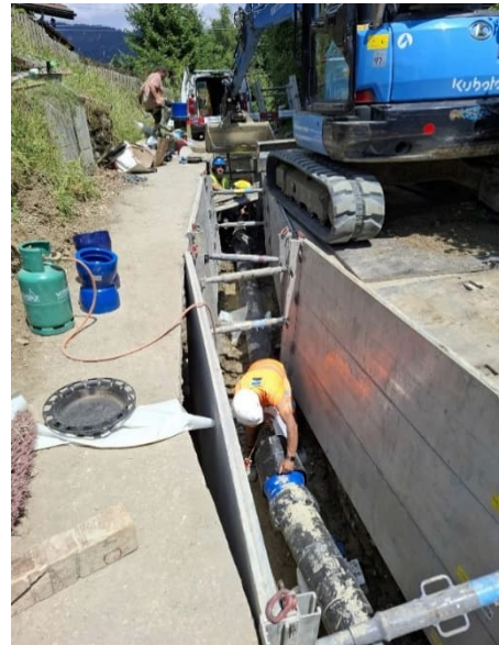
Route de la Cierne : pose nouvelle conduite de transport et alimentation
