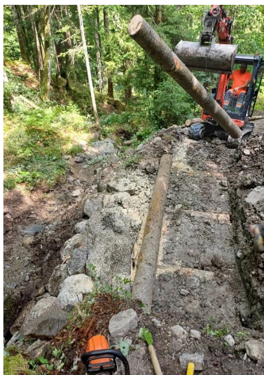
Chemin pédestre des Braseyres – Création d'un caisson en bois
