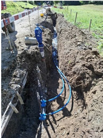
Chemin de la Rocasse : renouvellement de la conduite
