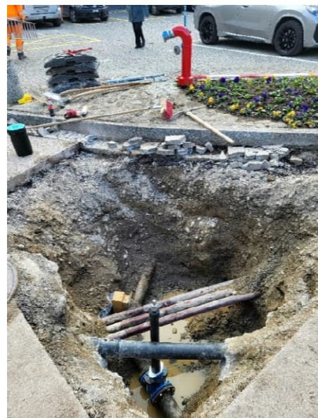
Place d'Armes : remplacement vanne borne hydrante no4
