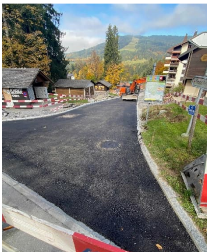
Pose du revêtement (couche de base)
