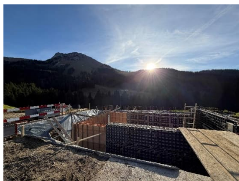
Coffrage nouvelle fosse
