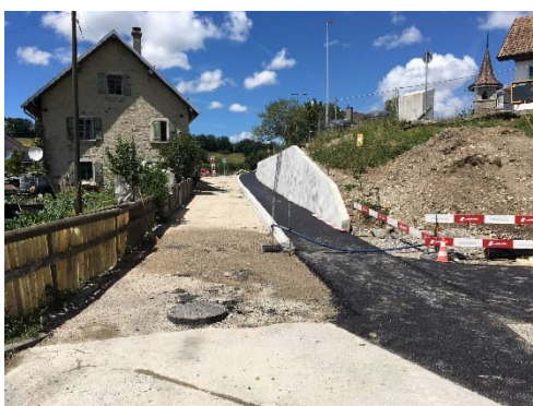
Pose du revêtement
