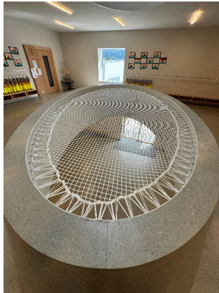
Puits de lumière protégé par un filet de sécurité
