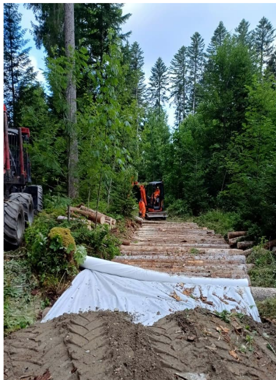
Piste forestière du Devin des Dailles – Pose de boudronnage
