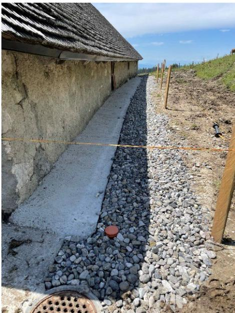
*Mise en place d'un drainage, côté montagne, au chalet de Bellechaux*
