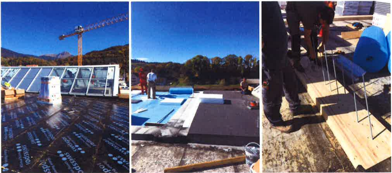
(Travaux sur la toiture du CAB)
