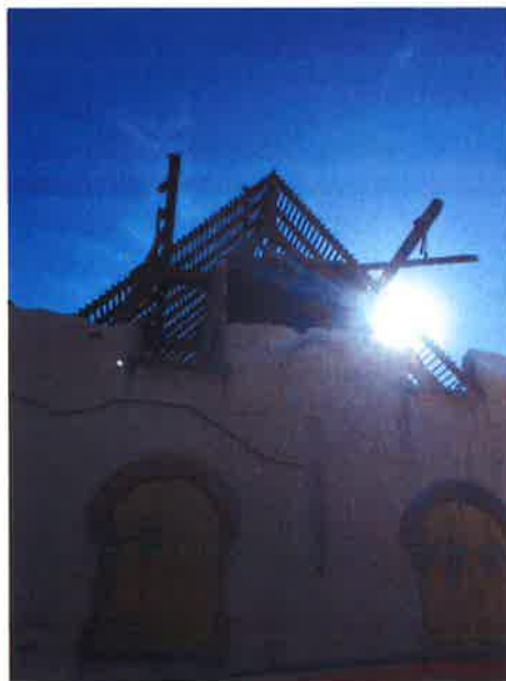
(Chantier de l'Ecole des Pléiades)
