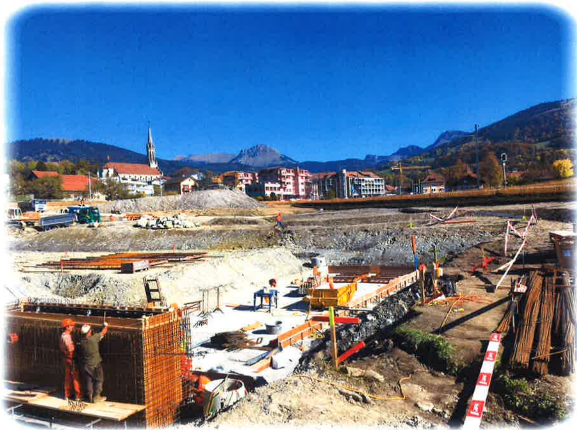
Début du chantier des travaux de la gare, Rte de Palézieux (octobre 2017)
