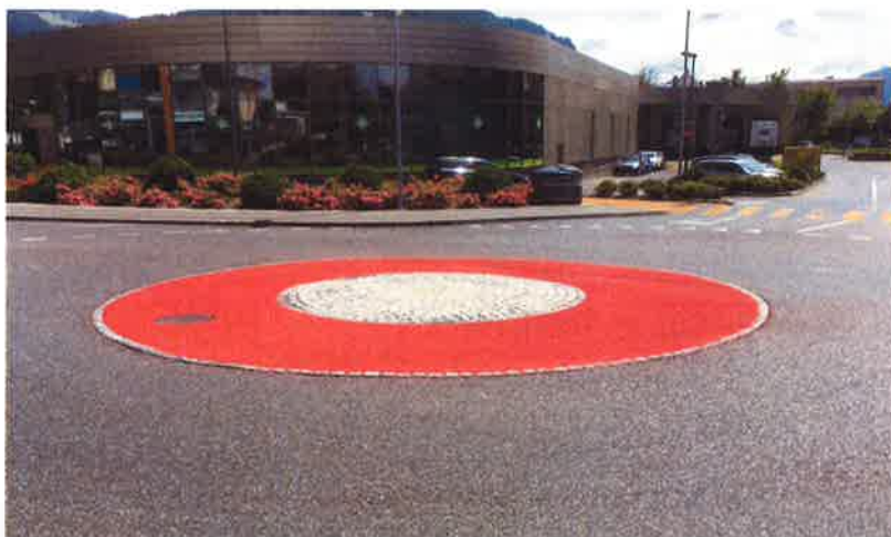
Giratoire de la Rte de Montreux
