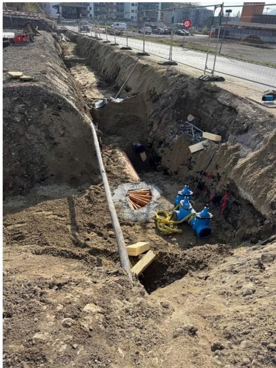
*Pose du collecteur d'eaux claires au Gottau, en parallèle de la conduite d'eau potable*
