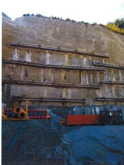
Paroi cloutée côté Ouest, sous la maison de Mme Pires
