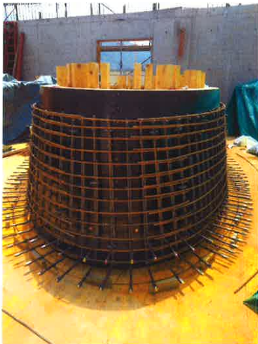
Coffrage de l'Ellipse qui servira de puits de lumière
