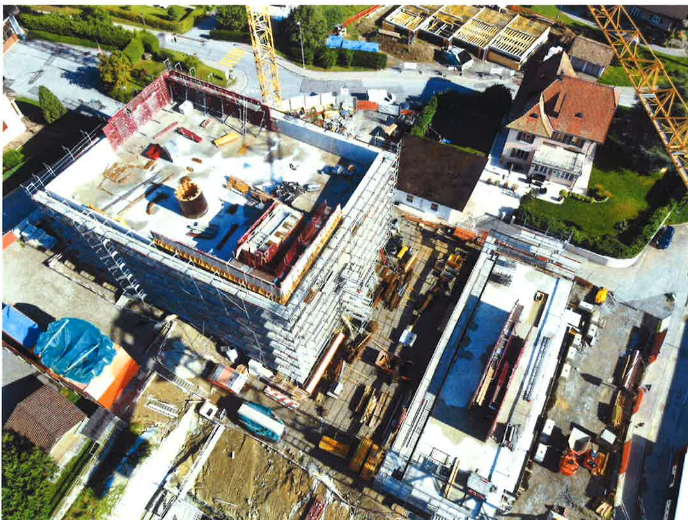
Vue de la nouvelle école des Pléiades : Bâtiment primaire et « La Glacière » qui abritera la salle de rythmique et le préau couvert.
