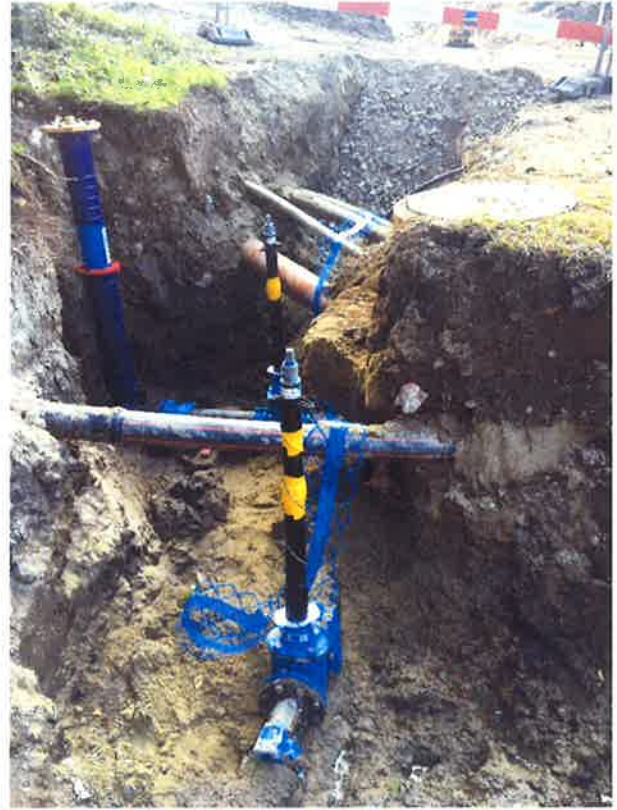
Chantier Les Joncs
