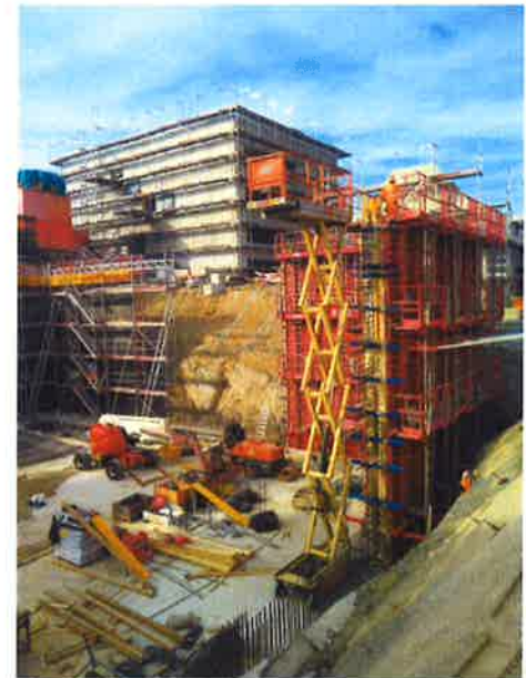
Coffrage des murs du Bâtiment infantine-sports
