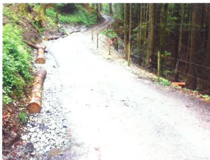
Photo après réfection
