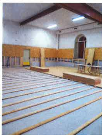
Mise en place du lattage technique
