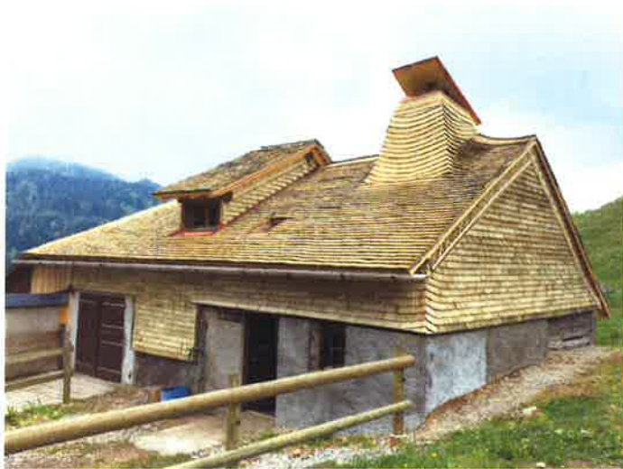
Chalet La Bria après les travaux
