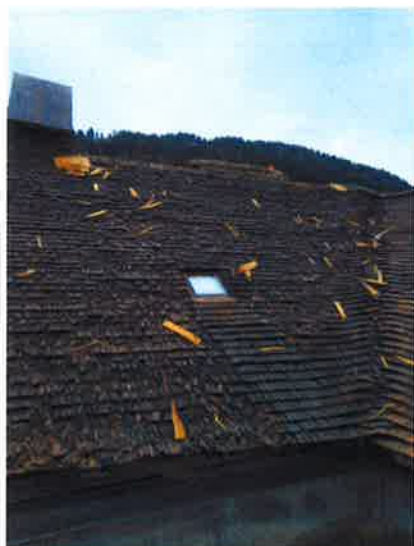
Toiture chalet La Bria avant les travaux
