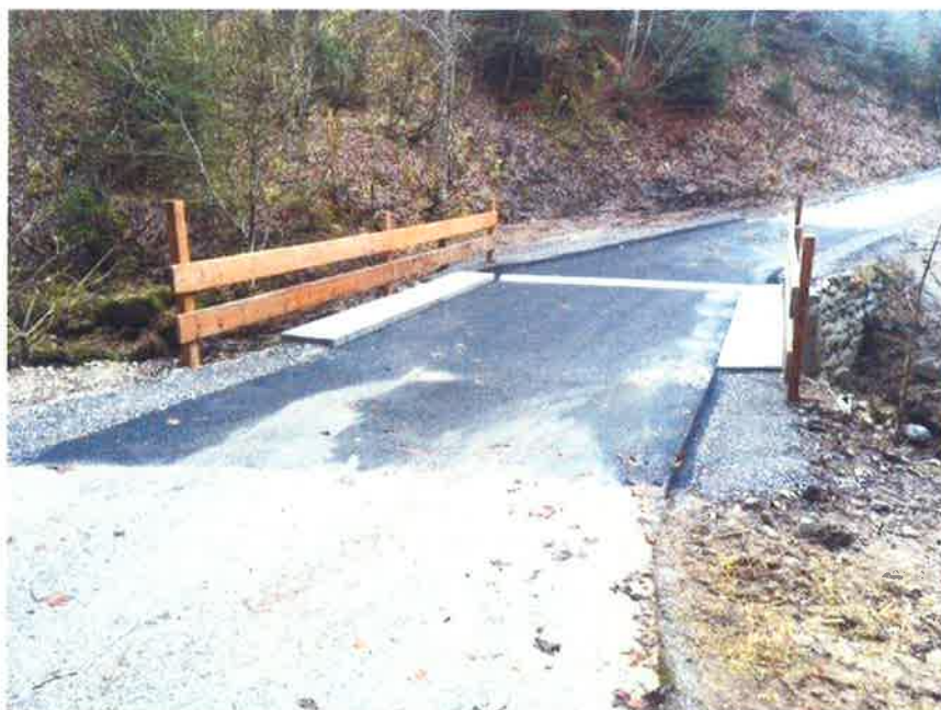
Pont de la Cuva après réfection
