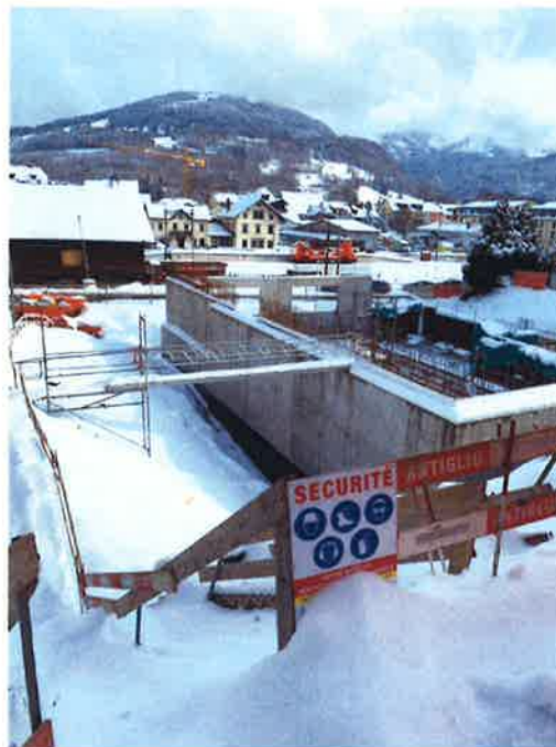
Le chantier est ralenti par les conditions météorologiques
