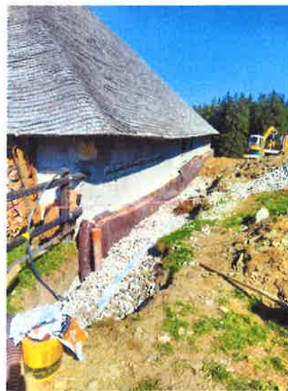
Installation de drainages au chalet Petit Molojy
