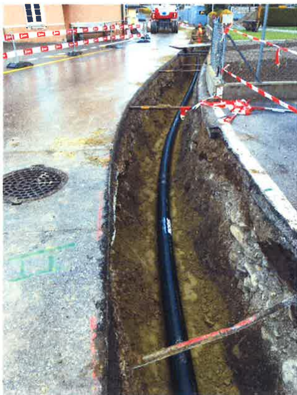
Chantier La Péralla
