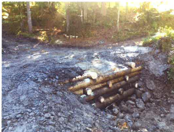
Photo après réfection
