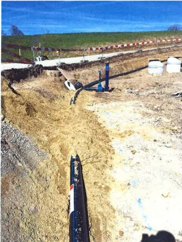
Chantier de Montmoirin
