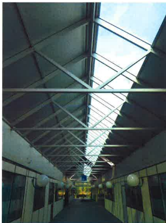
Couloir principal avec les nouvelles verrières
