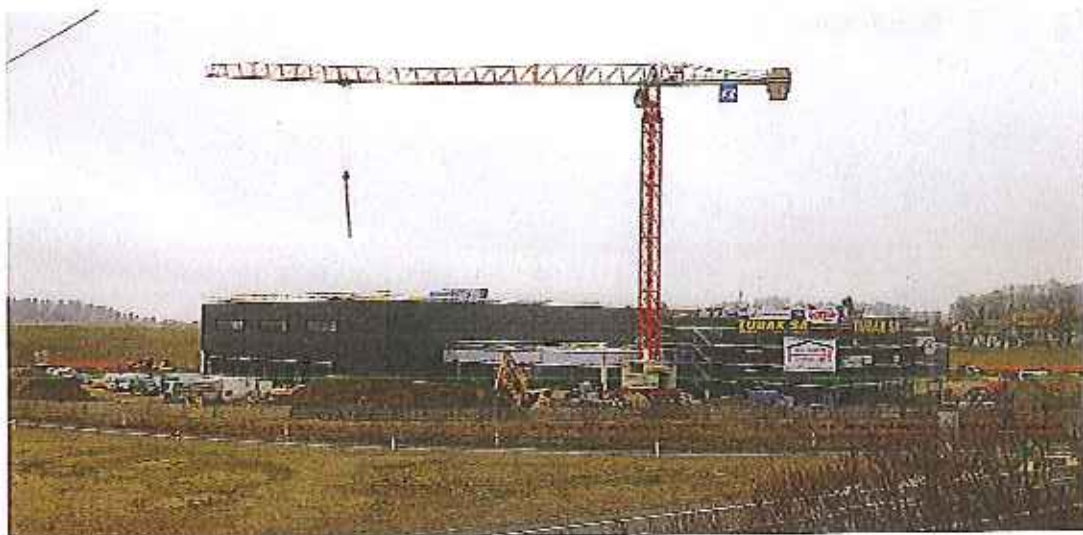
Construction de l'usine Marvinpac SA, Ch. des Assos
