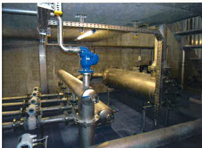
Arrivée des sources et traitement aux UV
